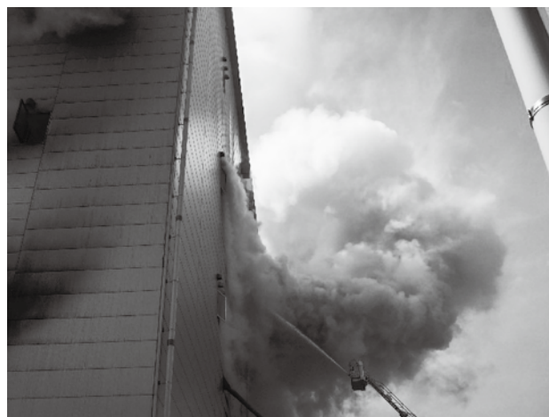
図5 大阪府大阪市大規模物流倉庫火災時のフラッシュオーバー発生時の様子
